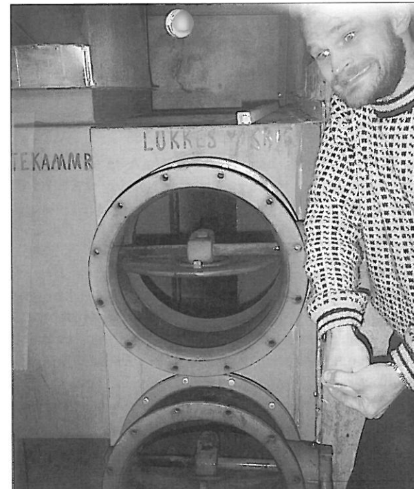
Lukkes i tilfelle krig. Sigbjørn Harboe demonstrerer lufteanlegget.
