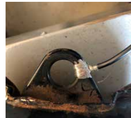
Jording, strømforsyning og Krystallsoda, elektrolyse på gang.
